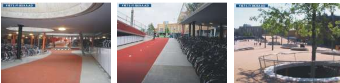
Ciclostazione di interscambio a Groningen, sotterranea, ben illuminata dalla luce naturale, con rampe di accesso comode e scorrevoli (fonte: Fietsberaad - NL)
