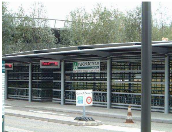
Überdachter Fahrradabstellplatz an einer Haltestelle (Véloparc in Straßburg)
