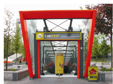
Eingang zu einem überwachten Fahrradparkhaus (Bildquelle: Fietsberaad)
