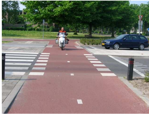
Zweispuriger Fahrradübergang mit Verkehrsinsel und Vorfahrt (Bildquelle: P. Kroeze)
