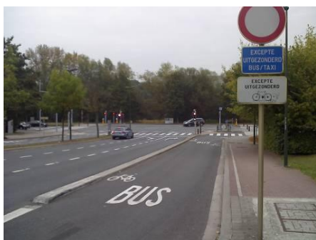
Autobusno-biciklistička traka s obilaskom za desno skretanje (pored semafora), sa zatvorenim profilom i simbolom bicikla na kolniku (D. Dufour)
