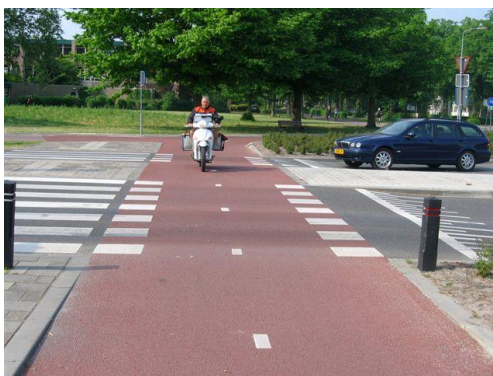
Островок безопасности на пересечении двухсторонней велодорожки, имеющей приоритет, с автодорогой (фото: P. Kroeze)
