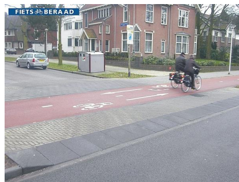
Пересечение двухсторонней велосипедной дорожки с примыкающей дорогой (фото: Fietsberaad)
