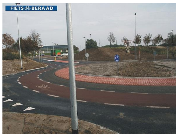
Велосипедная полоса, проходящая по центру дороги на кольцевой части перекрёстка (фото: Fietsberaad)
