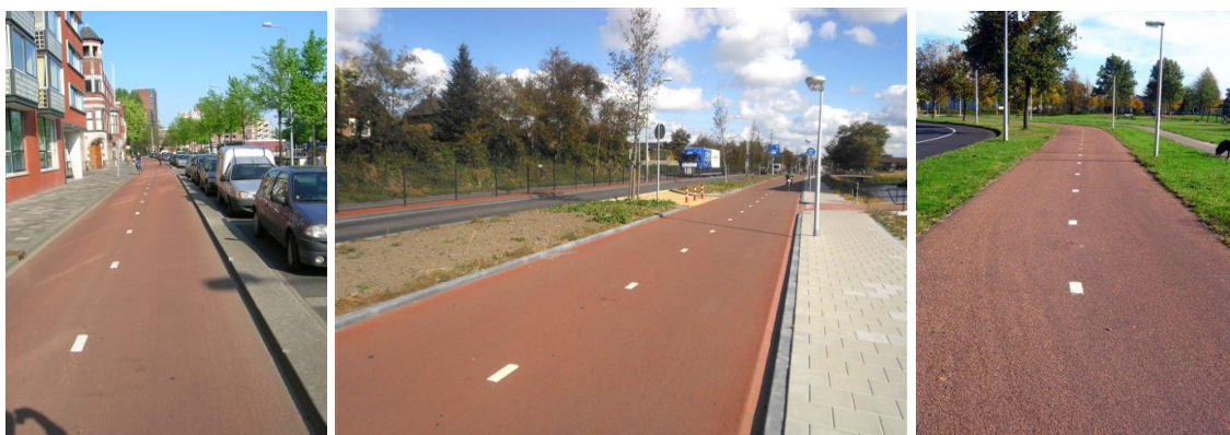
Велодорожки с двухсторонним движением, расположенные с одной стороны от автомобильных дорог (фото: P. Kroeze)
