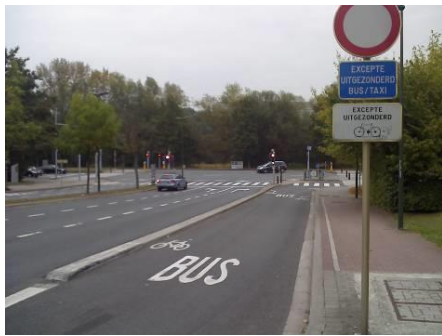
Автобусно-велосипедная полоса как способ предоставить автобусам и велосипедистам возможность повернуть направо без остановки на светофоре. Отделена от других полос движения delineатором. Разметка указывает кому разрешено движение по этой полосе (фото: D. Dufour)
