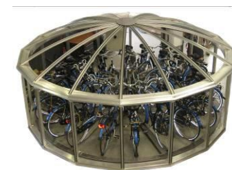
Веломельница (bicycle mill) в Nieuw-Vennep (Нидерланды): подземная парковка на 200 велосипедов в форме гигантских жерновов. Возвышается на 3 м над землей и занимает 9 м под землей. www.fietsmolen.nl
