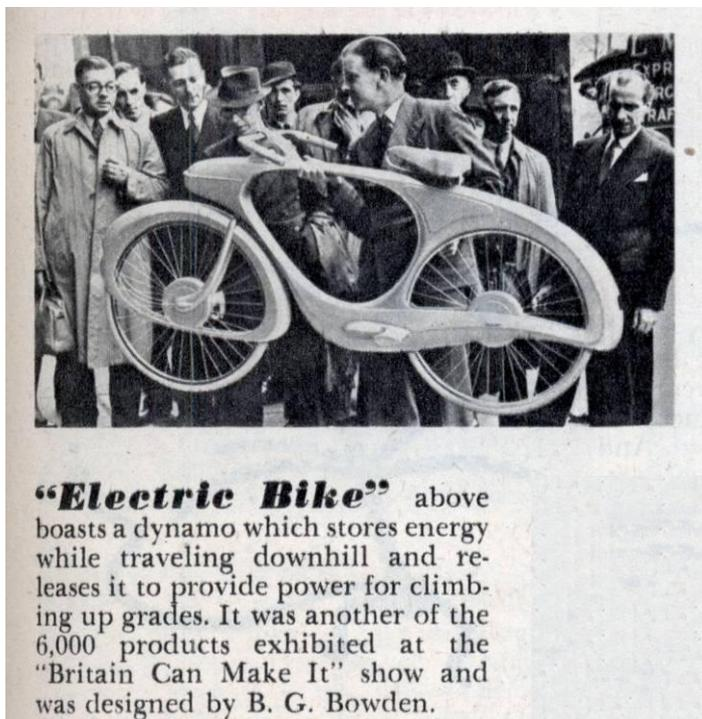
Figura 9: La bicicletta elettrica in fibra di vetro di Bowden, del 1947
