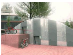
Fabrika e biçikletave në Hollandë: parkim nëntokësor për 200 biçikleta, në formë fabrike, 3m sipër tokës, 9 m poshtë. www.fietsmolen.nl
