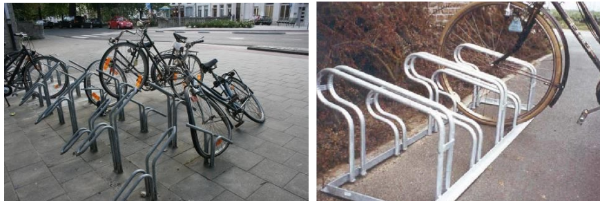
Mbështetëset me rrotë të parë horizontale DUHEN SHMANGUR (burimi i imazhit: T. Asperges)
