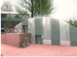
"Bicycle mill" (mulino delle biciclette) a Nieuw-Vennep in Olanda: parcheggio sotterraneo che può alloggiare 200 biciclette a forma di mulino gigante che si sviluppa per 3m sopra il suolo e per 9 m sotto. [www.fietsmolen.nl](http://www.fietsmolen.nl)
