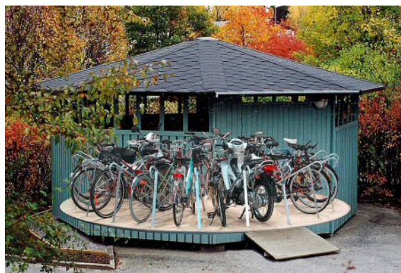
Karuzelowy boks rowerowy: rowery spoczywają na ręcznie obracanej platformie która umożliwia postawienie roweru naprzeciw wejścia z pojedynczymi drzwiami (Szwecja, por. videoklip www.plug.se )
