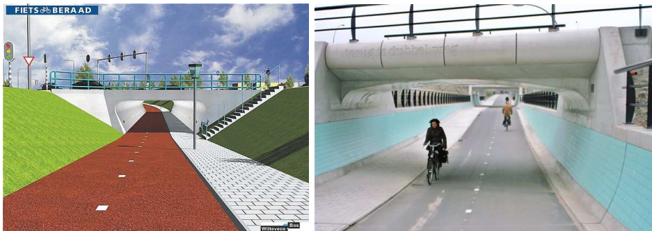
Gute Ausführung eines Fahrradtunnels und guter Fahrradtunnel (Bilder: Fietsberaad, P. Kroeze)
