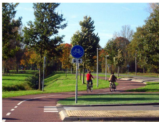
Traversée de vélos avec piste courbée vers l'extérieur (crédit photo : P. Kroeze)
