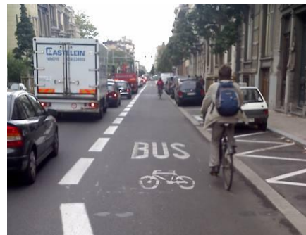
Una corsia per autobus/biciclette stretta che consente di evitare il traffico congestionato, con profilo aperto e simboli di bicicletta (D. Dufour)
