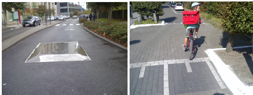
Przyjazne dla rowerów pionowe i poziome elementy redukujące prędkość (źródło zdjęć: D. Dufour)
