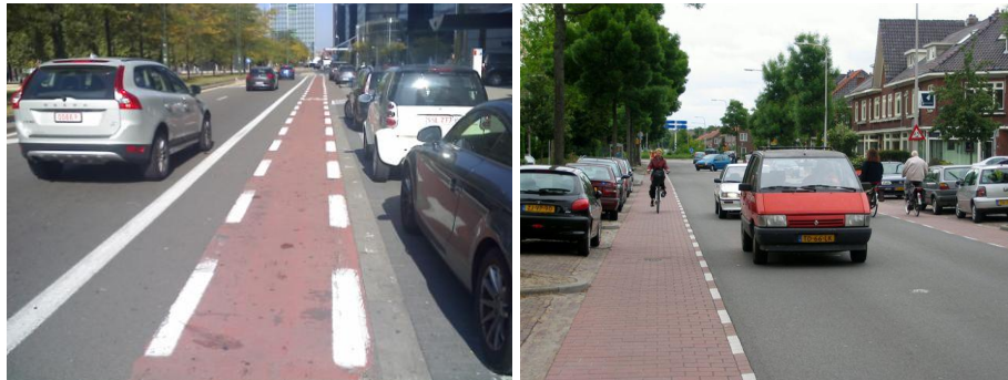
Piste ciclabili su corsia riservata con distanza di sicurezza da automobili parcheggiate e in movimento (fonte immagini: D. Dufour)
