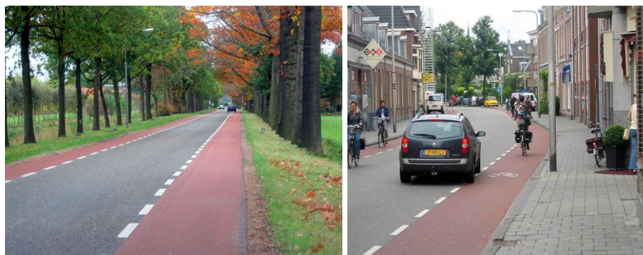
Bandes cyclables en dehors et à l'intérieur des agglomérations (crédit photo : P. Kroeze)
