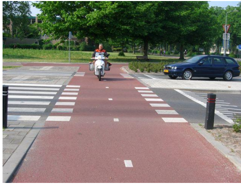
Korsia e pedalimit me dy-drejtime që kalon ishullin e trafikut me të drejtë kalimi (burimi i imazhit: P. Kroeze)
