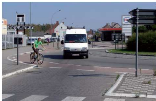
Die Gefahren eines Fahrradstreifen in einem Kreisel (Quelle Vademecum fietsvoorzieningen – Brüssel)
