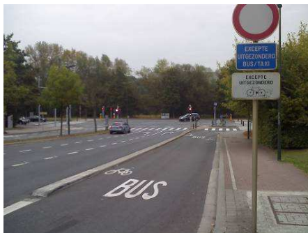
Bus-/Fahrradspur als Ampelumgehung für Rechtsabbieger mit einem geschlossenen Profil und Fahrradstraßensymbolen (D. Dufour)
